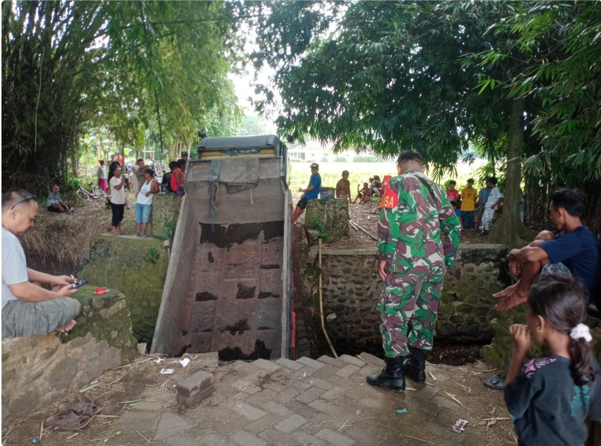
Pada saat Terjadinya Jembatan Roboh 1 Dum Truk Pasir akan melewati jembatan tsb dalam Rangka Mengantar Pesanan Pasir dari Ds Tinos gambar dan Langkap. Penyebab Jembatan Roboh dikarenakan Muatan 1 Ran Dum truk yg melebihi Kapasitas Beban Berat Jembatan. Kendaraan masih dalam Proses Pengangkatan dari Pinggir sungai.
